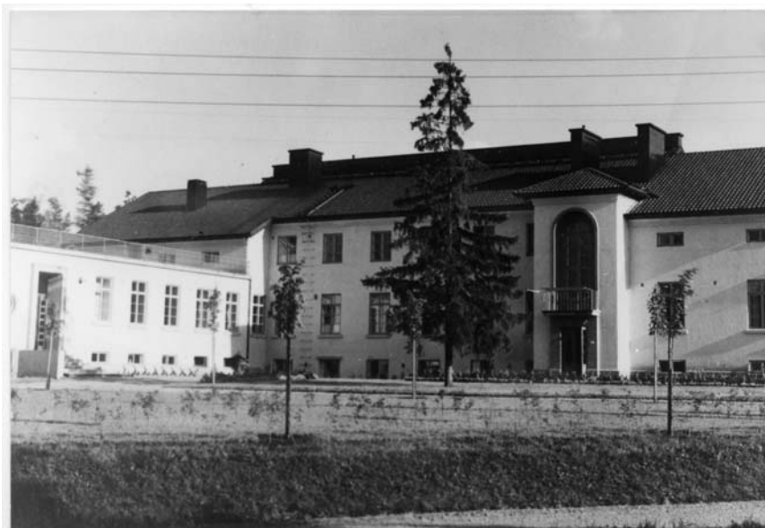
Enson sairaala laajennustyön jälkeen.
