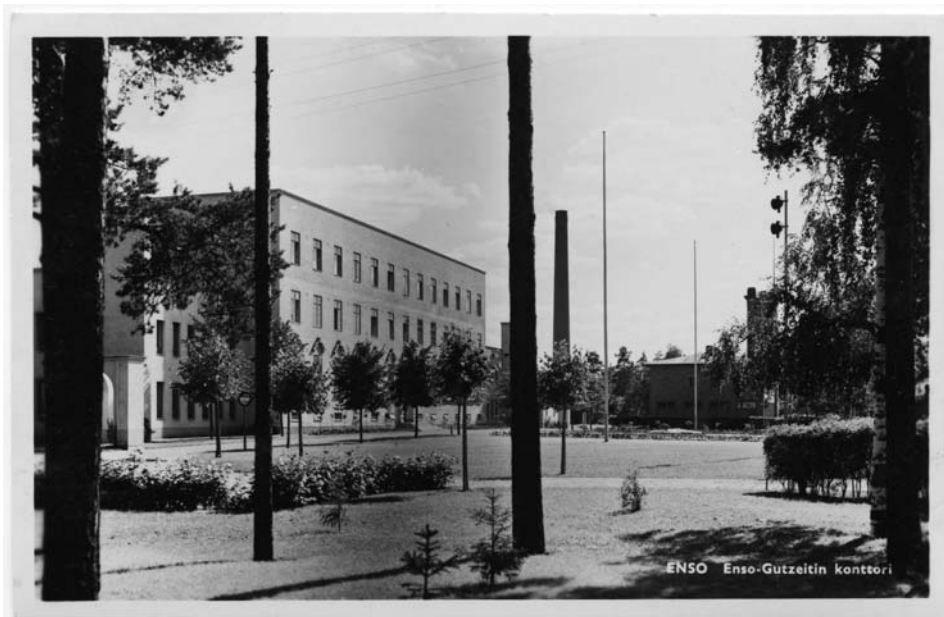
Enso-Gutzeit Oy:n pääkonttori korjauksen jälkeen.
